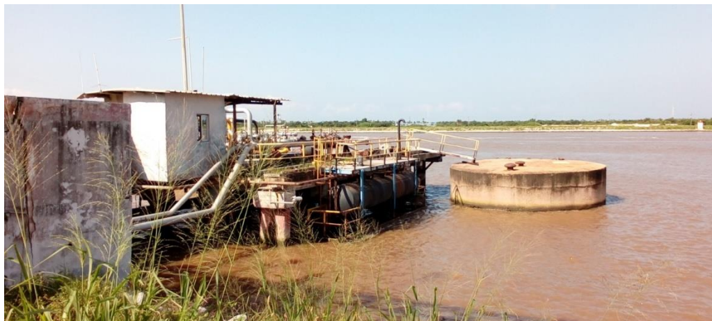
Photo 1 : Appontement SIAP vétuste et abandonné depuis 2008 (cliché : Siaba F.)
