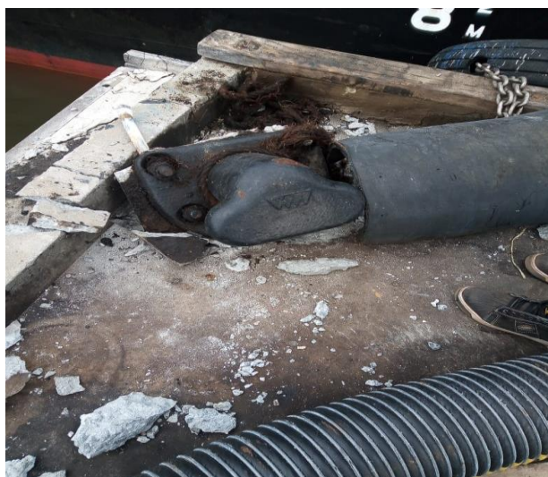
Photo 3 : Bollard cassé au quai PETROCI (Cliché : Siaba F)
