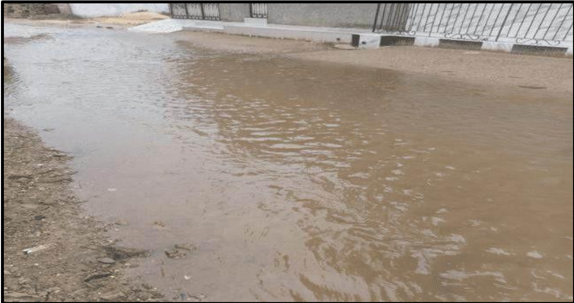
Photo 1 : Eaux ruisselantes (S. SY, septembre 2023)
