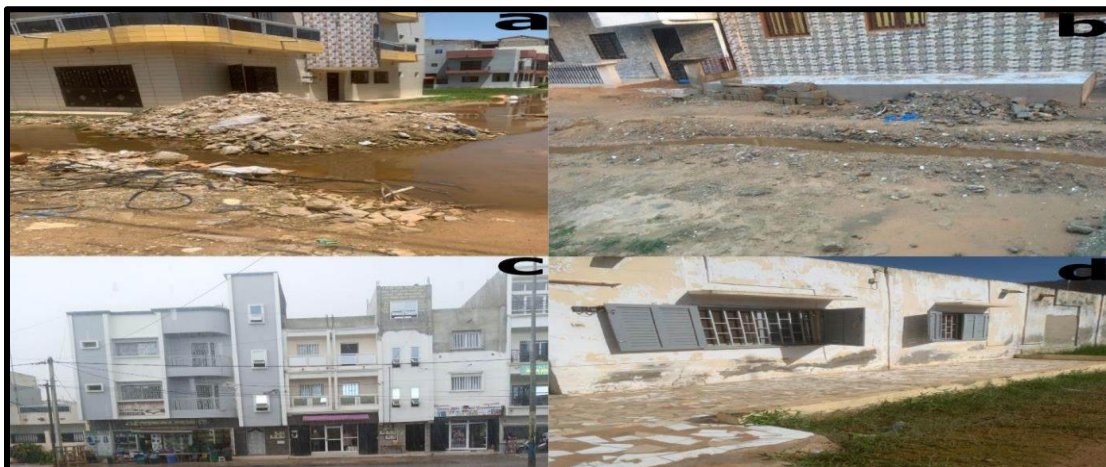
Planche 3 : Méthodes des ménages : a) Gravats ; b) Drainage artificiel ; c) Fermeture des espaces extérieurs ; d) Ventilation naturelle favorisée par le vent (S. SY, août-septembre 2023)
