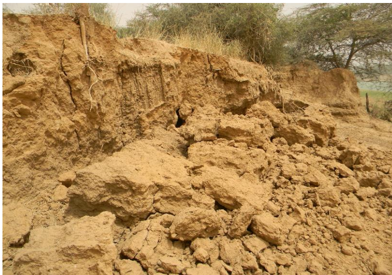
Photo 3 : Rupture en plaques à Saré Souki Source : Cliché GUEYE A., février 2019
