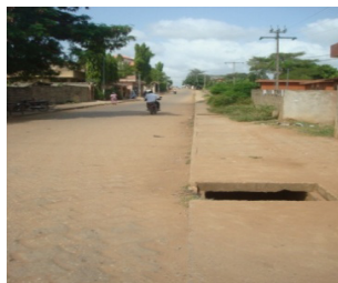
Photo 4 : Caniveau ouvert derrière SOS
