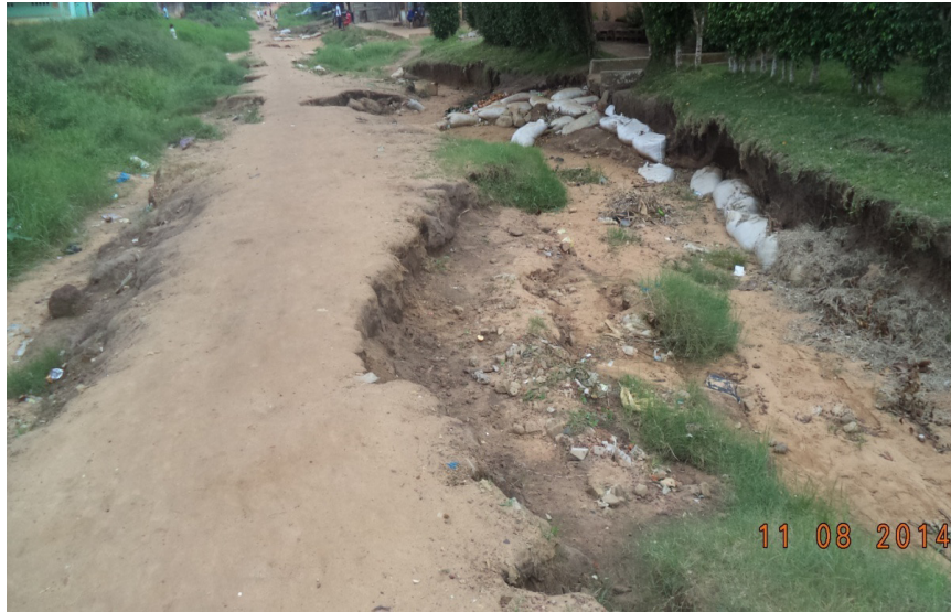
Photo n° 1 : Vue d'une voie érodée au quartier Sodepalm à Dabou
