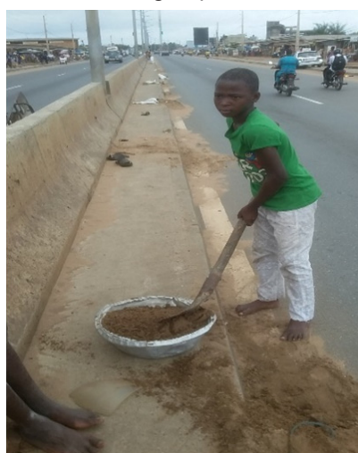
Photo 4 : Un sablonnier occasionnel
