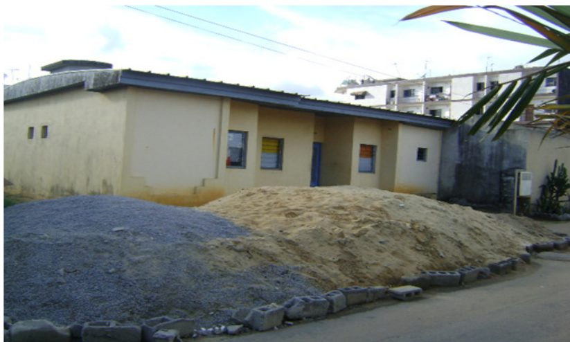
Planche 1 : Aspect initial d'une villa clés en main semi-accolée vue de l'extérieur de l'opération immobilière 03001 de la SICOGI à la Riviera-Palmeraie. Au premier plan, on observe un amoncellement de sable et de gravier qui témoigne de la volonté de cet acquéreur d'entamer des modifications de son logement. Au deuxième plan, on remarque l'absence de clôture et de grilles de protection aux fenêtres. (Source : Diabagaté A, 2014)
