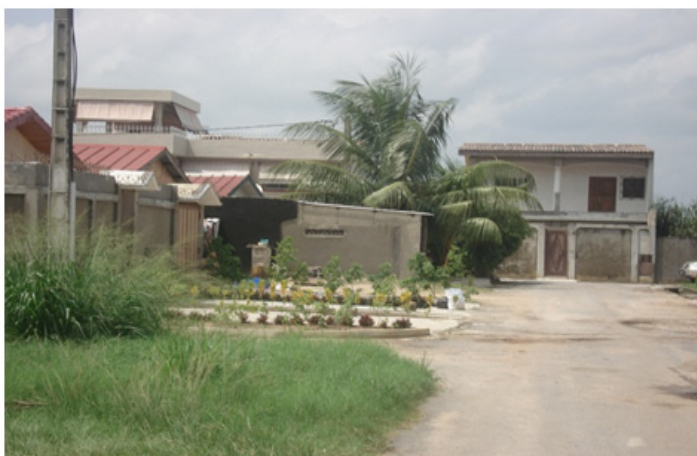
Photo 5 : Au second plan on observe l'extension d'une villa en violation des servitudes d'alignement. (Opération immobilière Lauriers 8, Riviera-palmeraie, Coulibaly A, 2013)
