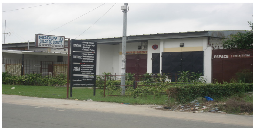
Photo 4 : Villa de l'opération immobilière SICOI-Palmeraie aménagée pour abriter plusieurs commerces. (Coulibaly A., 2013)
