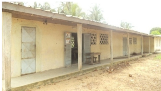
Cliché : Dosso, 2015 Photo 7 : Une école de six classes construite par des pêcheurs à Mélékougro
