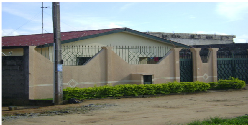
Photo 3 : Modification personnalisée à forte portée esthétique caractérisée par une façade embellie dans l'opération immobilière Lauriers 8. (Coulibaly A., 2014)
