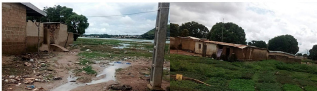
Planche 1 : Une habitation aux abords du barrage dans un cadre de vie malsain (à gauche) et des habitats précaires construits en banco (à droite) ; (Clichés : A.J. DJAH, Septembre 2019)
