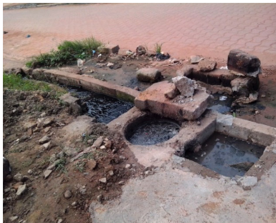
Photo 1 : Réseau d'assainissement saturé au quartier Poro 1 (Cliché Michel T., 2014)
