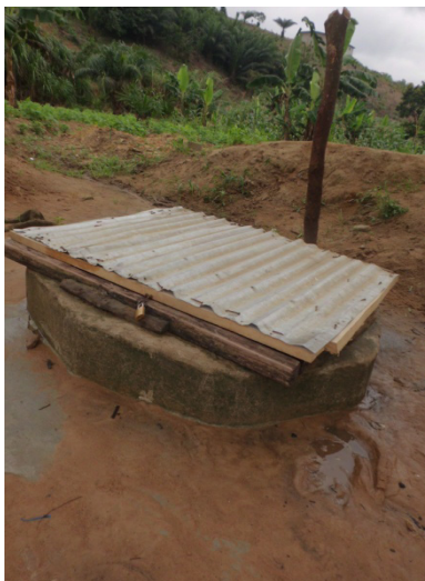
Photo 4 : Photo 4 : Puits commerciale au quartier BC Source: Mme Awomon 2015
