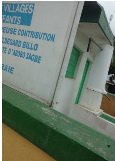
Photo 2 : Borne fontaine en panne à Sagbé
